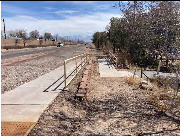
ADA access ramp
